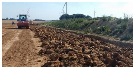
Vue de la piste de roulement après restructuration au bulldozer et ripper.
