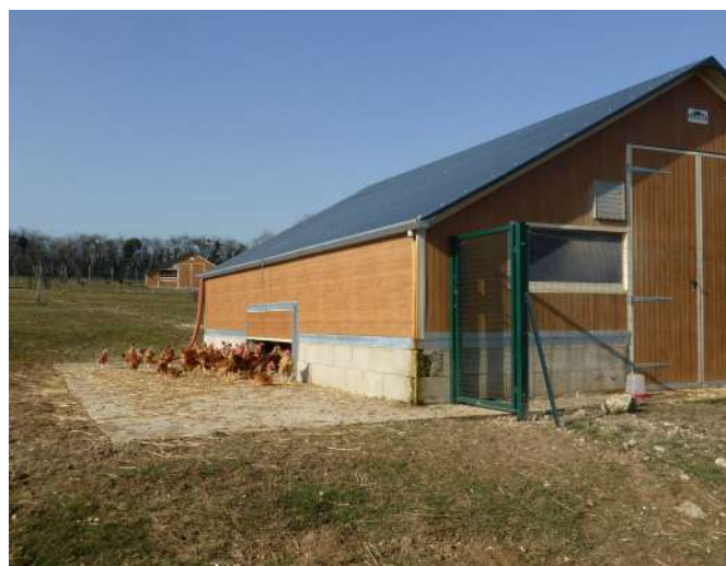
Bâtiment et volailles de chair bio au lycée agricole d'Airion (60)
