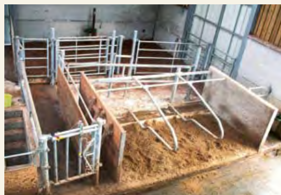
Box de contention : Box placés à l'arrière des logettes.
