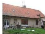
Unité bâtie 1 : Corps de logis
