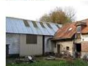
Unité bâtie 2 : orange/Ancienne écurie
