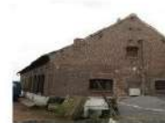
Unité bâtie 1 : Corps de logis
