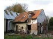
Unité bâtie 2 : Ancienne écurie
