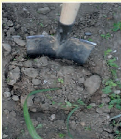
Figure 1 : Creuser la prétranchée
