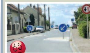
L'équipement doit rester franchissable par le matériel agricole et conforme aux guides CERTU/CEREMA\*. Il faudra vérifier les épures de giration<sup>1</sup> et veiller à l'implantation du mobilier urbain.
