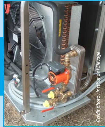
Récupérateur de chaleur pré-installé sur tank neuf.
