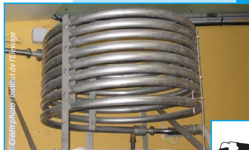
Pré-refroidisseur tubulaire
