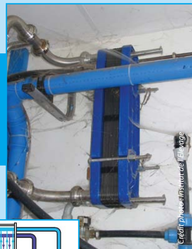
Pré-refroidisseur à plaques
