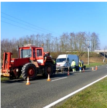
Réalisation de sondages sur des voies publiques
