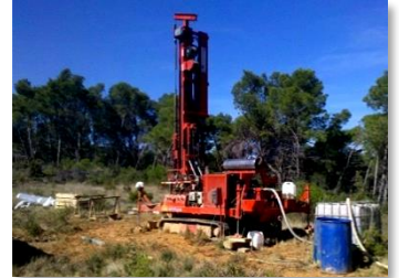
Machine pour réaliser les sondages carottés
